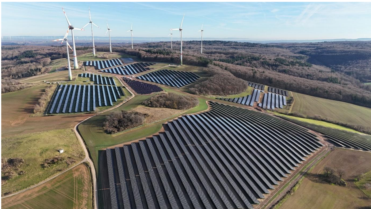
Solarpark Schneebergerhof, Rheinland-Pfalz (©wiwi consult)
