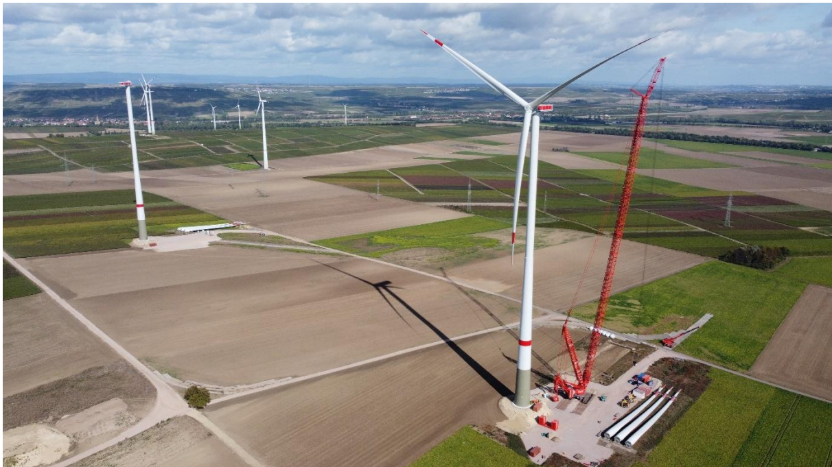
Entstehender Windpark in Gau-Bickelheim, Rheinland-Pfalz (© wiwi consult)
