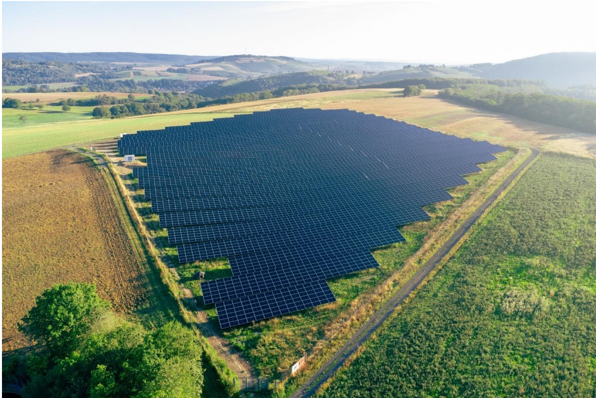
Solarpark Waldböckelheim, Rheinland-Pfalz (© wiwi consult)
