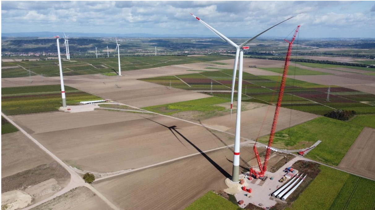
Entstehender Windpark in Gau-Bickelheim, Rheinland-Pfalz (© wiwi consult)
