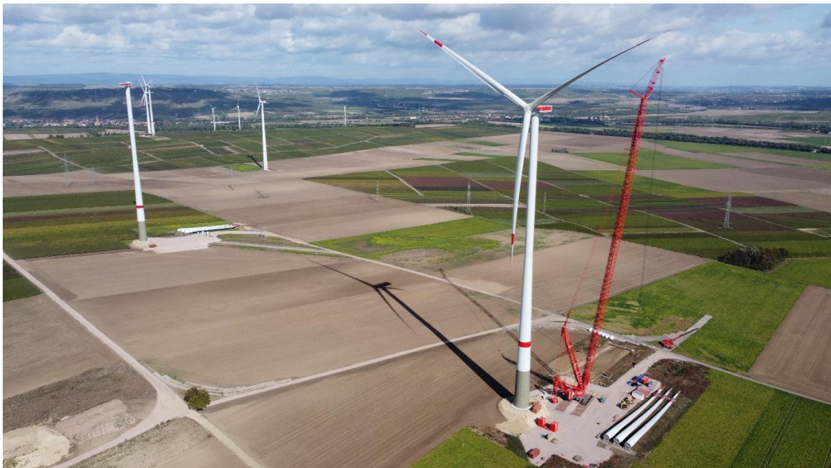
Entstehender Windpark in Gau-Bickelheim, Rheinland-Pfalz (© wiwi consult)
