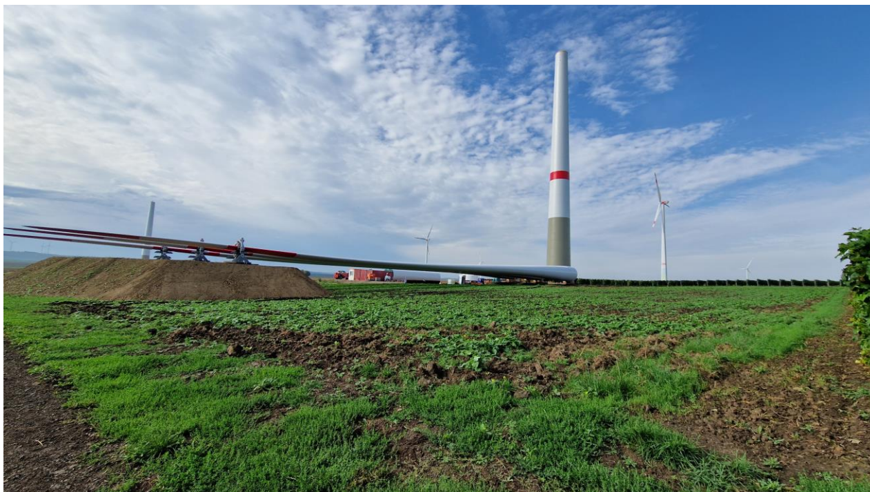
Entstehender Windpark in Gau-Bickelheim, Rheinland-Pfalz (Foto: wiwi consult)
